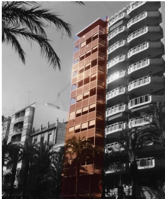
Edificio Alfonso el Sabio nº 40 Año: 1962 Arquitecto: Juan Guardiola Gaya Dirección: Avda. Alfonso el Sabio nº 40, Alicante
