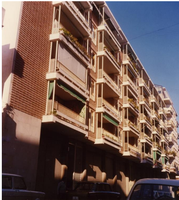
Edificio Marqués de Molins nº 52
