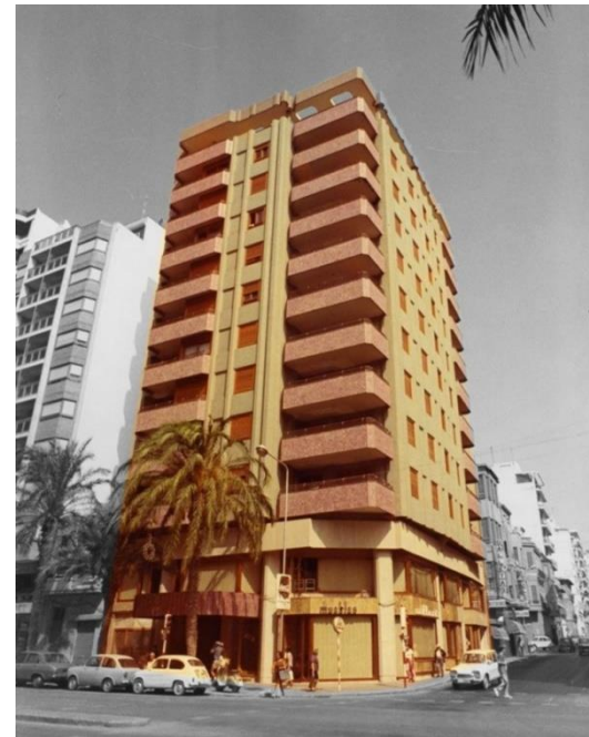
Edificio Alfonso el Sabio nº 14
