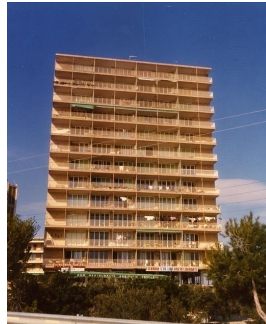
Urbanización Vistabella 2 Año: 1960 Arquitecto: Juan Guardiola Gaya Dirección: Avda. de la Condomina 17, Alicante
